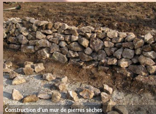
Construction d'un mur de pierres sèches
